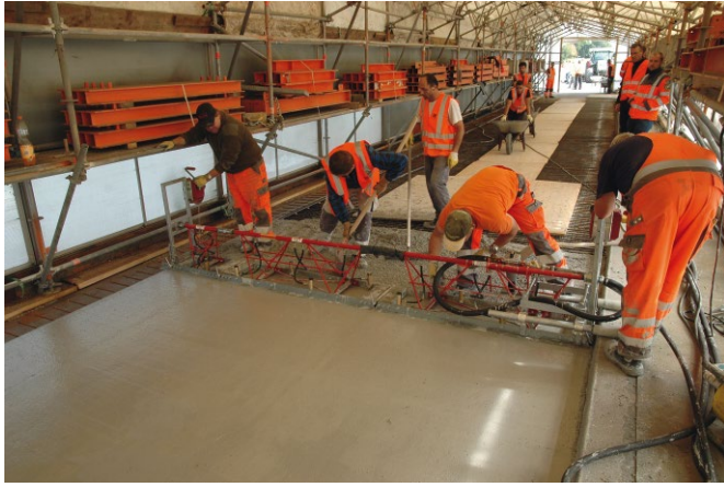
Bild 2 Händische Betonage mit Rüttelbohle unter Schutzzelt beim Pilotprojekt Beimerstetten Manual concreting with vibrating beam within a protective tent during Beimerstetten pilot project
