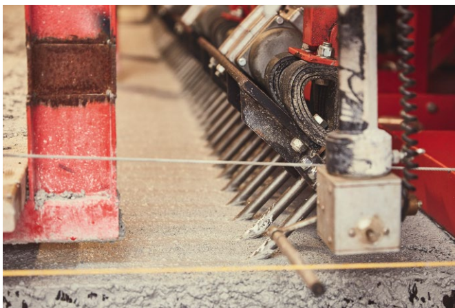
Bild 7 Detailaufnahme der Rüttelfinger des Einbaufertigers im hochfesten Beton Close up of vibrating rods of concrete paver within the high performance concrete
