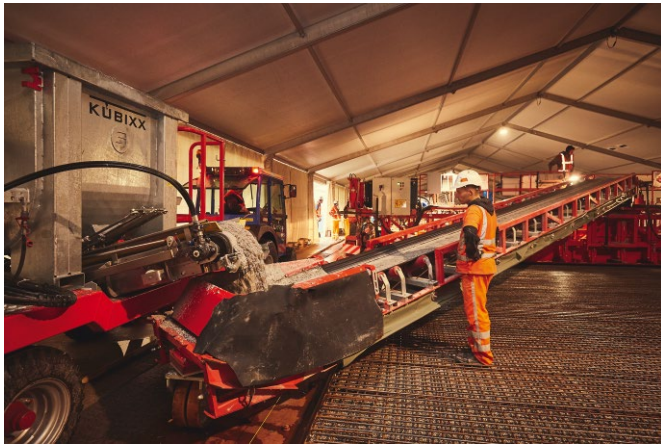
Bild 6 Übergabe des Betons aus Kubixx an das Förderband des Einbaufertigers Transfer of concrete from Kubixx to conveyor belt of concrete paver
