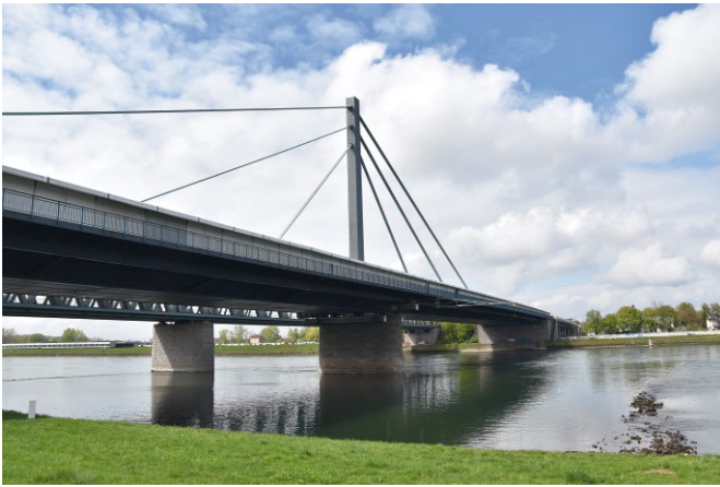
Bild 1 Ansicht der B 10 Rheinbrücke Maxau mit Schutzzelt Overview of the B 10 Karlsruhe Maxau Rhine-bridge with protective tent
